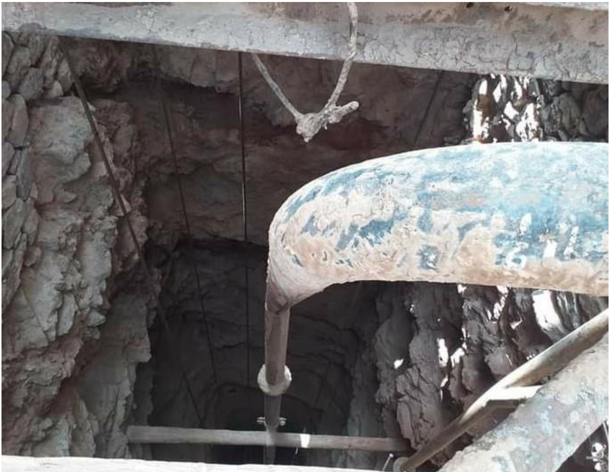
PHOTOS GISEMENT MIBLADEN SECTEUR 3 : CONDUIT PERMETTANT À L'AÉRATION
