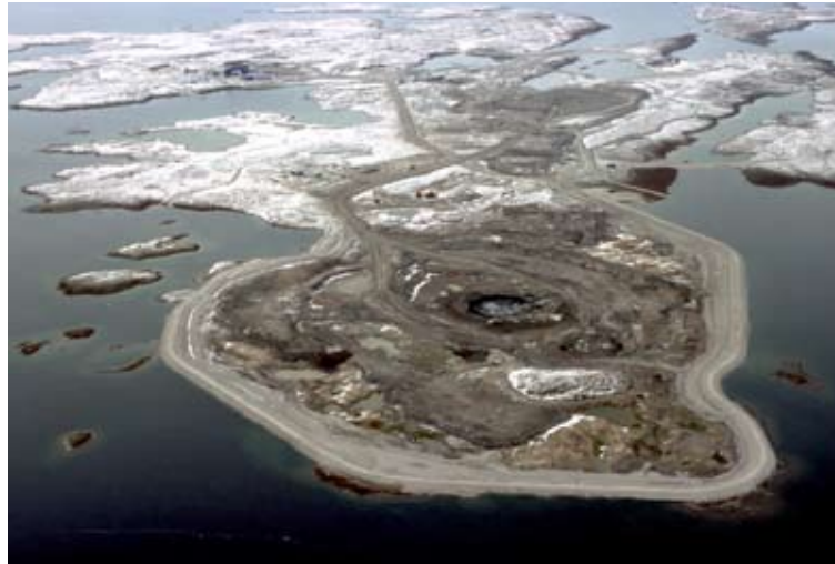
Figure 2.11 Vue aérienne de la cheminée A154 de la mine Diavik. Gracieuseté de Diavik Diamond Mine Inc.
