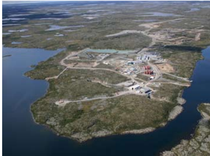
Figure 2.14 Vue aérienne du site de la mine Snap Lake, dans les Territoires du Nord-Ouest. Gracieuseté de De Beers Canada.
