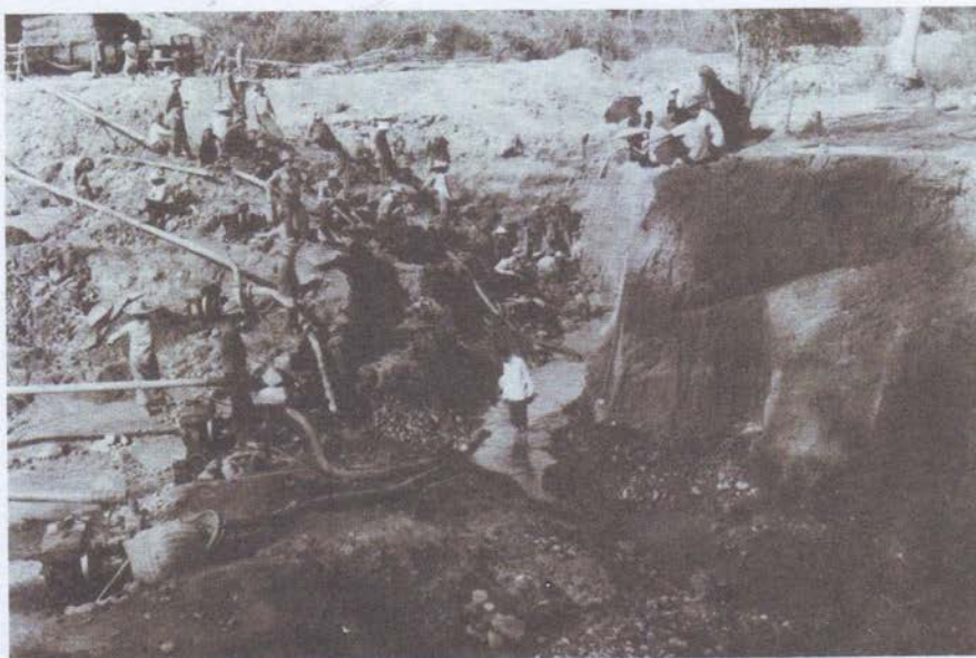
PHOTO 1. — Grande tranchée alluviale sur l'O' Tapuk. Le niveau minéralisé est atteint. Noter les multiples motopompes évacuant les eaux d'infiltration et l'exploitant surveillant sous son ombrelle les travaux.
