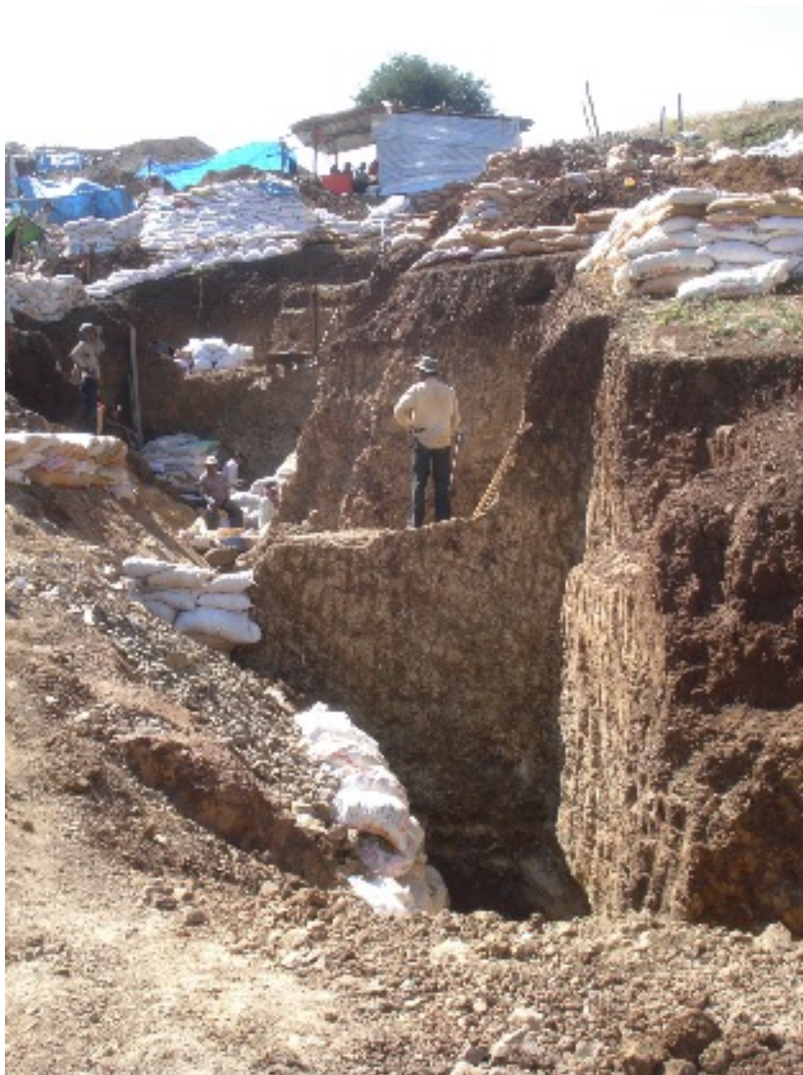
Figure 19 : Vue générale de la mine d'or
