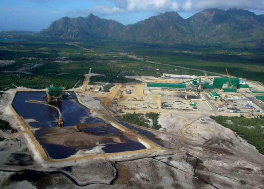
Figure 8 : Le projet QMM (Ilménite, Fort Dauphin). Photographie : ejatlas.org.
